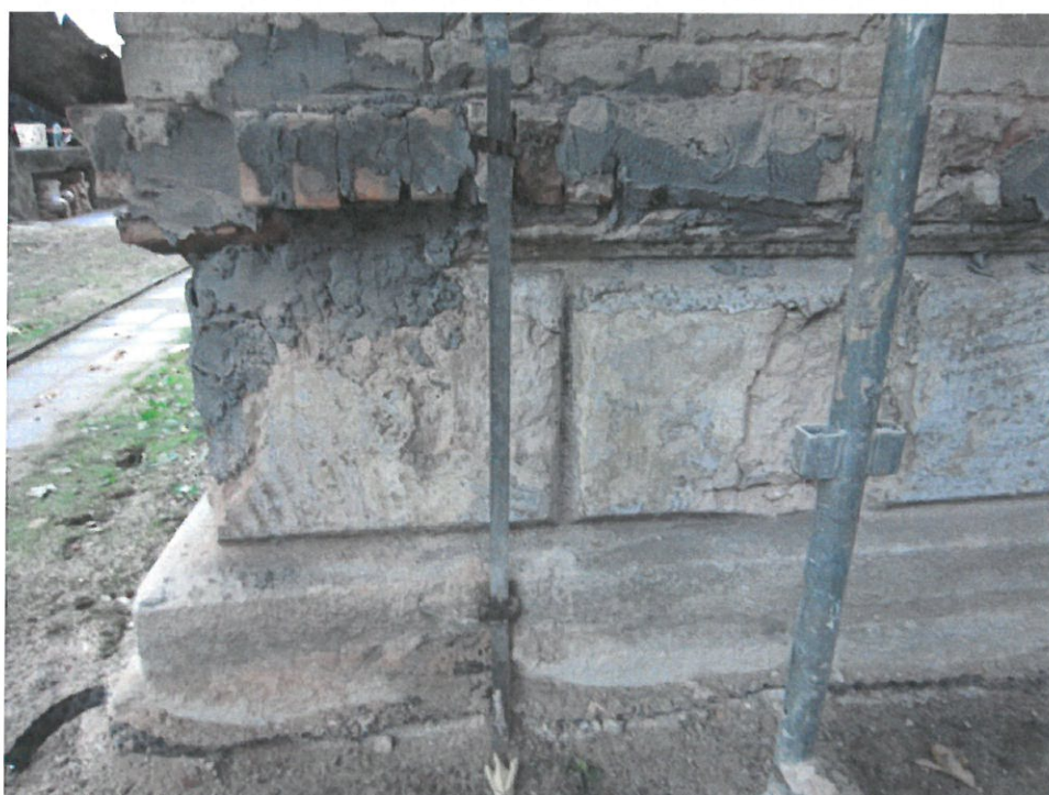
Fot.5. Fragment cokołu kamiennego na narożu ryzalitu na ścianie północnej budynku, po usunięciu cementowych nawarstwień i wtórnych uzupełnień.
